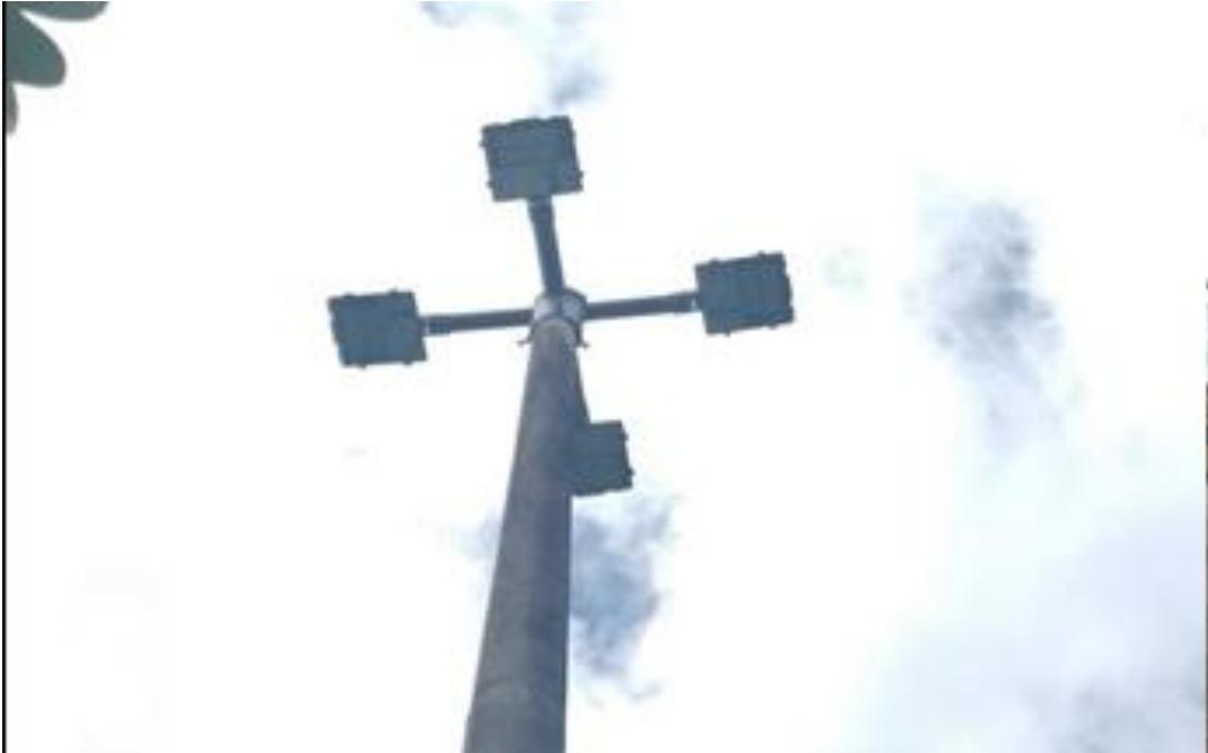
4 - Substituídos 04 luminárias convencional para LED 100w em suportes de fixação já existentes
